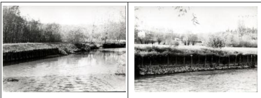
Archivio del Consorzio del fiume Olona: “passonata” in legno con pali di castagno o robinia, talvolta rinforzata al piede con ciottoli fluviali, effettuata come protezione spondale per limitare l’erosione. Questo sistema è stato utilizzato sul fiume Olona fino agli anni '50.
